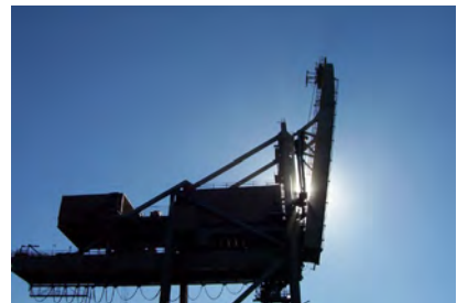
Ore Unloader 3 BlueScope Steel
